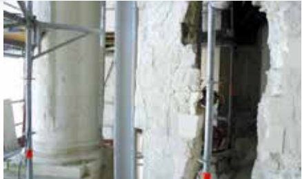
Poutre métallique mise en place le long de la façade sur sommier en béton, décollée des assises moulurées. Mur entre les piliers en cours de débouchage
