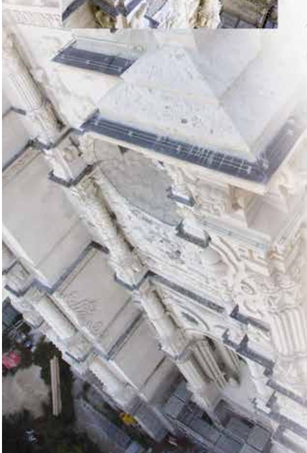
▲ Gouttières posées au-dessus d'une corniche protégée de plomb | Octobre 2007
