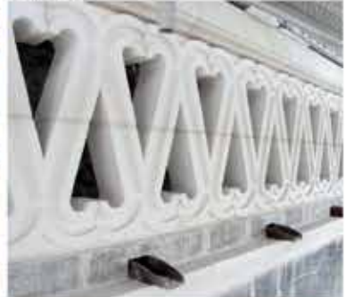
▲ Gouttières dans la nouvelle balustrade de la tour sud (découverte lors de la restauration et reprise à l'identique de celle de la tour nord) | Mars 2012
