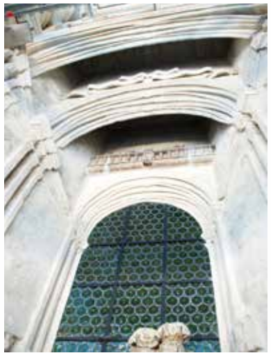
Après : la baie réouverte avec nouvelle structure métallique et vitraux à cives, de chaque côté, les murs de remplissage | Octobre 2007
