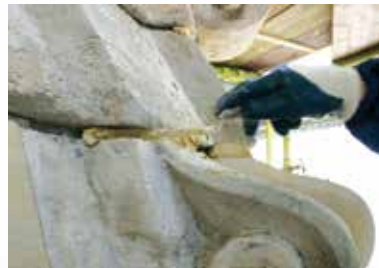
Le maçon nettoie et consolide les pierres qui peuvent être conservées. Il enlève le mortier dégradé par le temps et l'humidité et rejointoie les pierres | Octobre 2004
