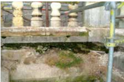
Balustrade avant restauration et présence de végétaux. A ce niveau, le monument se sépare en 3 flèches (le dôme central et les deux tourelles) | Mars 2005
