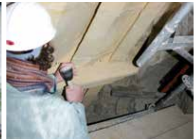
↓ Habillage en pierre neuve de la poutre métallique et taille
