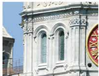
Reconstitution à gauche d'une fenêtre avec vitraux en trompe-l'œil Juillet 2005
