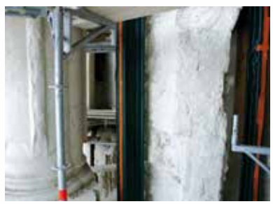
Poutrelles métalliques enrobées de géotextile | Novembre 2008
