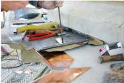
Les outils utilisés : battes, pics à fer, à relayer, caillots, borescut...
