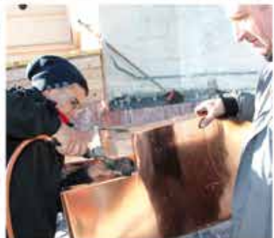
▲ Pose de la couverture en cuivre sur les barreaux latéraux des tours nord et sud, de la face sud des parties basses avec réalisation de charpente | Décembre 2009
