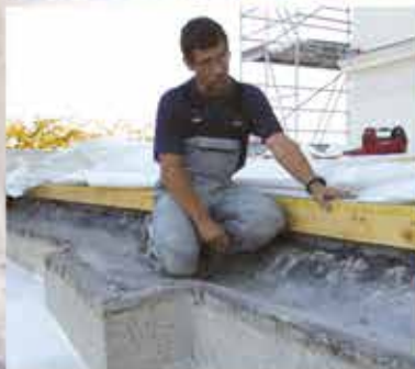
▲ Pose de la couverture en cuivre sur les barreaux latéraux des tours nord et sud, de la face sud des parties basses avec réalisation de charpente | Décembre 2009
