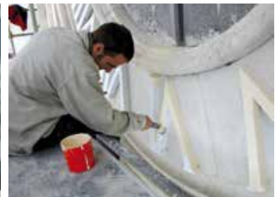
Pose de la mixtion avant dorure | Septembre 2007
