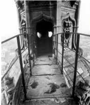
▲ Ouvrir restauration de la passerelle reliant le grand dôme à la tour elle sud
