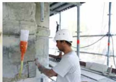
Une injection de coulis de chaux est effectuée pour cimenter les éléments entre eux | Septembre 2011
