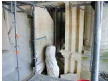
↓ Avant habillage de la poutre. Mise en évidence des profils moulurés et dégagement d'une statue adossée
