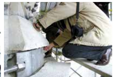
Pour le grand dôme du monument, un chaînage en inox est installé pour consolider et stabiliser la structure et il est ensuite recouvert d'un parement en pierre | Novembre 2004
